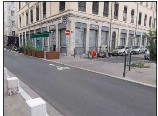
Trottoir traversant, Rue Salomon Reinach, Lyon 7 e
