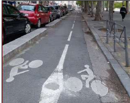
Suppression des potelets, Quai Augagneur, Lyon 3 e
