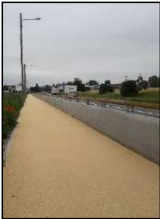
Revêtement drainant, Genay
