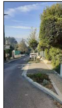
Chicane végétalisée, Rue du Bacon, Montanay
