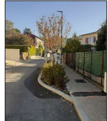
Chicane végétalisée Rue du Bacon, Montanay
