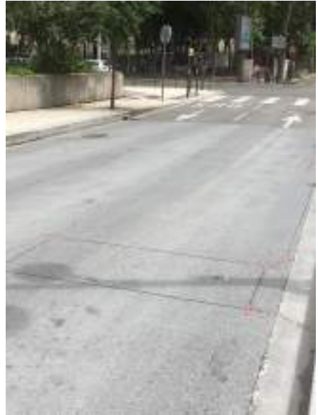
Boucle catégorielle pour la détection TC
