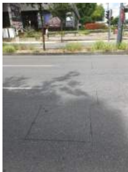
Boucles de macro-régulation assurant les comptages CRITER
