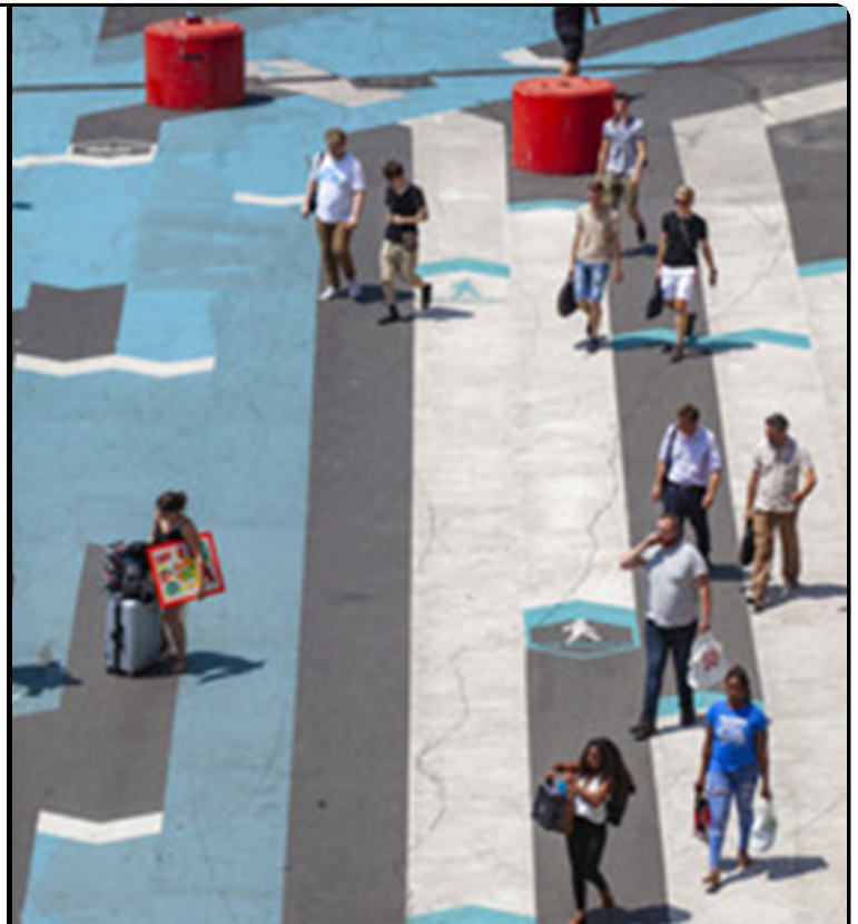
ABORDS GARE PART-DIEU EN CHANTIER
