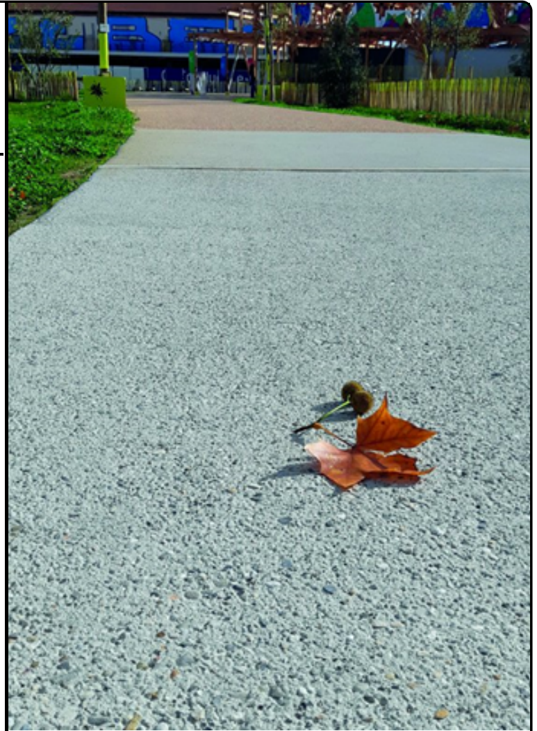
BÉTON RECYCLÉ À LA CONFLUENCE
