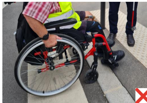
Petites roues d'un fauteuil bloquées sur un ressaut d'abaissé de trottoir
