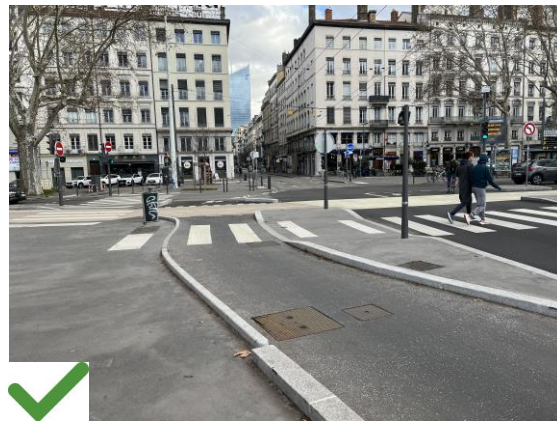
Piste et trottoir sont délimités à l'aide d'une bordure émergente. Les espaces sont clairement détectables et le risque de conflit limité.
