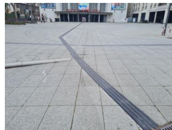
Bandes de guidage qui mènent à l'entrée d'ERP
