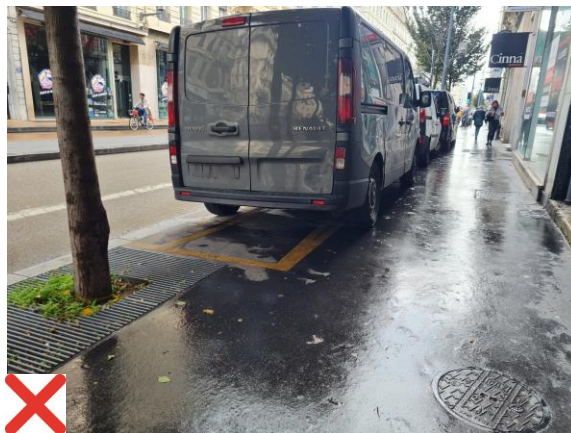
Place de livraison marquée sur le trottoir Les véhicules empiètent sur le cheminement piéton
