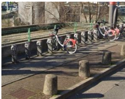
Photo 3 : surélévation du parc d'arceaux par rapport au cheminement piéton
