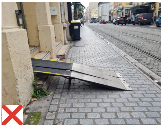
Rampe provisoire qui représente un obstacle voire un danger pour les piétons sur le trottoir
