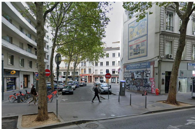
Avant réaménagement : une place importante accordée à la voiture
