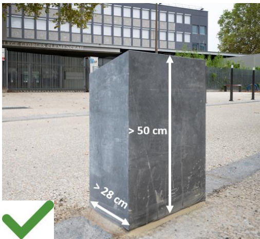
Exemple de borne respectant l'abaque de détection
