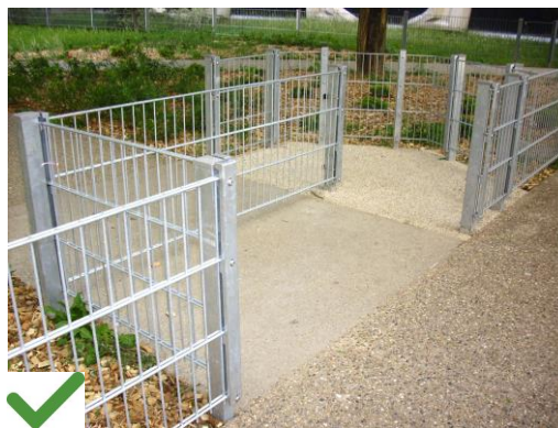
Chicane permettant le passage d'une personne en fauteuil
