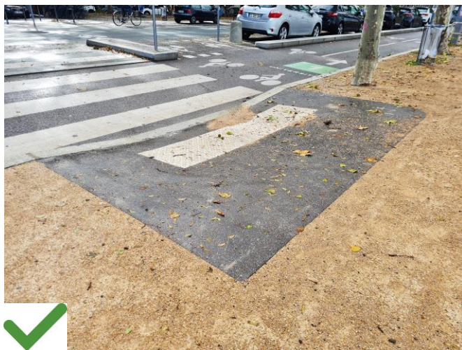
Pièce d'asphalte réalisée dans le sablé pour poser correctement la bande d'éveil de vigilance
