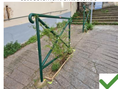
Végétalisation réalisée en pied de barrière qui ne gêne pas le cheminement piéton.
