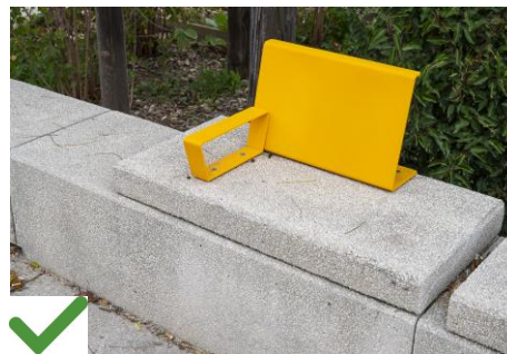
Assises réhaussée et équipée d'un accoudoir qui peut permettre le transfert depuis un fauteuil
