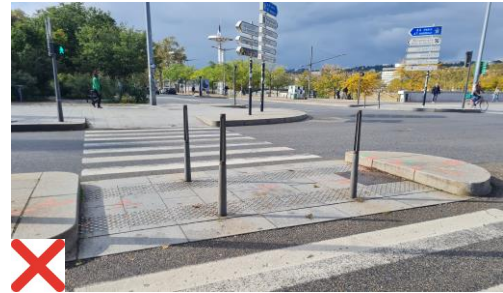
Les potelets présentent peu d'utilité sur cet ilot piéton et ils ne respectent pas l'arrêté du 15 janvier 2007 (contraste et détection)
