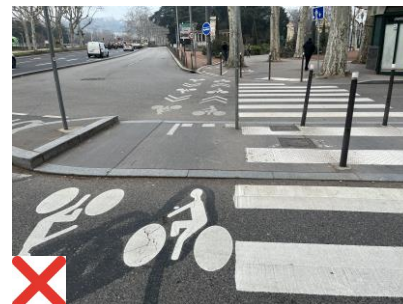
La limite entre espace piéton et espace cycle sur cet ilot-refuge n'est pas détectable
