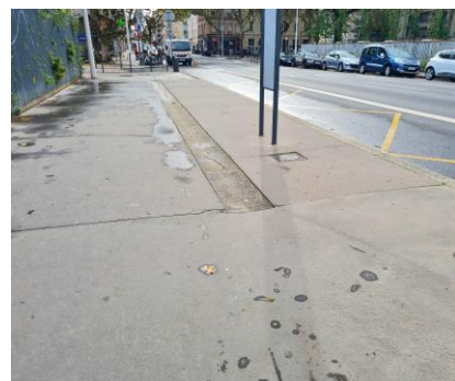
Figure 3 : Le trottoir fait office de quai. Un caniveau a été aménagée pour gérer les eaux pluviales.
