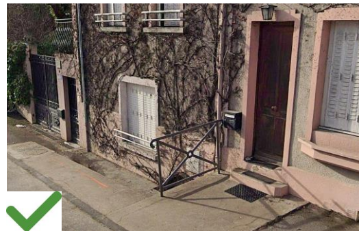
Installation d'une barrière PMR pour éviter tout risque de chute
