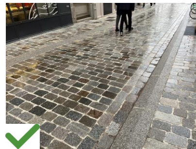
Pavés lyonnais sciés qui améliorent l'accessibilité de ce revêtement
