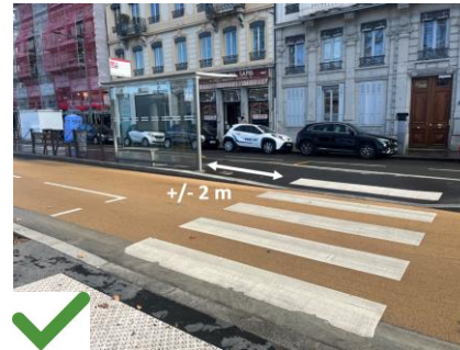
Le passage piéton est distant d'au moins 2m. La visibilité est assurée.
