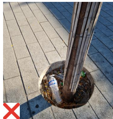
Pied d'arbre trop profond qui peut être dangereux pour un piéton déficient visuel
