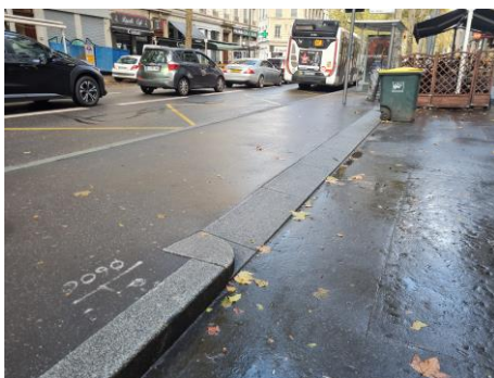
Figure 2 : Rampe courte et pentue aménagée à l'arrière du quai.
