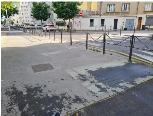
Figure 1 : barrières implantées sur le trottoir d'un parvis d'école pour sécuriser les enfants
