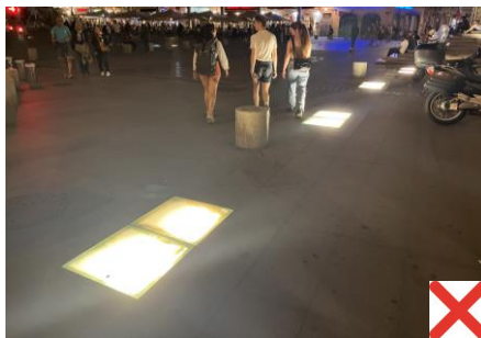
Éclairage éblouissant à éviter
