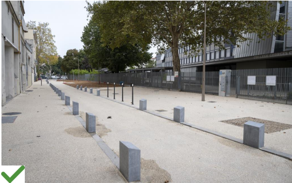
Zone de rencontre aménagée aux abords d'un collège – Des bornes contrastées et détectables ont été posées pour empêcher le stationnement et protéger les cheminements piétons
