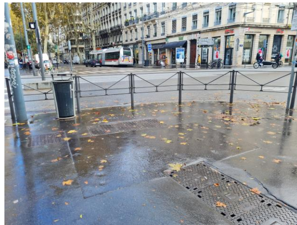
Figure 2 : barrières implantées en carrefour pour canaliser les piétons vers les traversées aménagées
