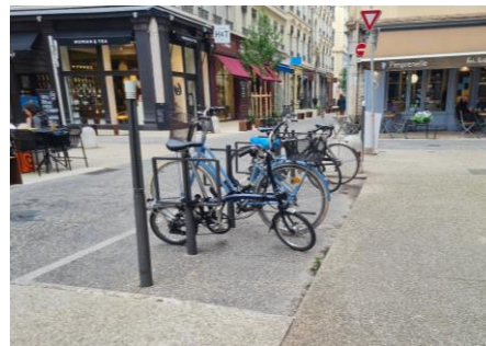
Photo 4 : zone d'arceaux positionnée au même niveau que la chaussée
