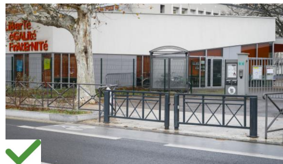
Barrière implantée en retrait du cheminement piéton. Elle ne gênera pas le cheminement en position ouverte.
