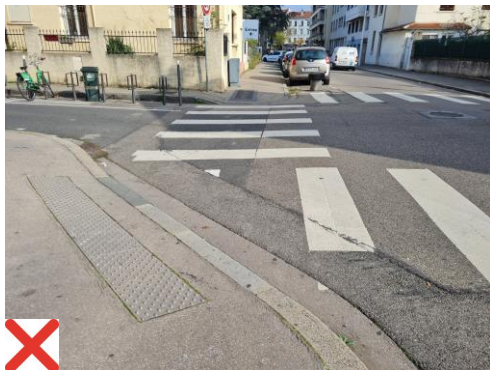
Passages piétons qui se chevauchent = problème de lisibilité pour certains publics
