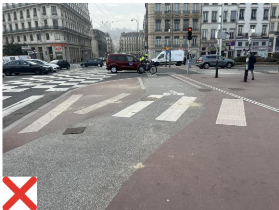
Aucune délimitation entre piste et trottoir n'est prévue à l'approche du carrefour.
