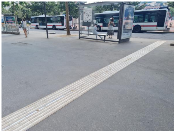
Dispositif d'interception expérimenté sur un quai bus
