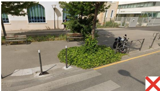
Végétaux non entretenus qui empiètent sur la bande d'éveil de vigilance
