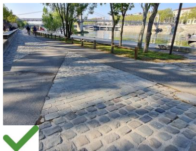
Sciage des pavés pour créer un passage accessible
