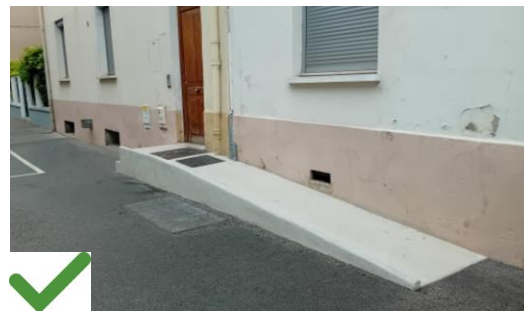
Création exceptionnelle d'une rampe sur le domaine public pour ne pas condamner l'accès riverain. Le trottoir a été élargi.
