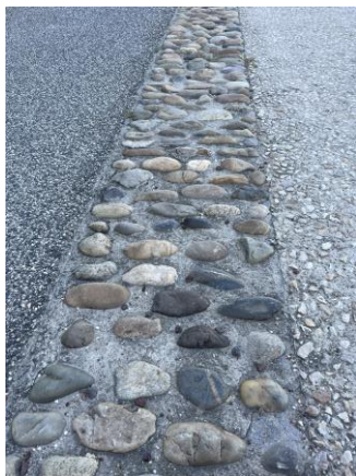
Séparateur franchissable et détectable
