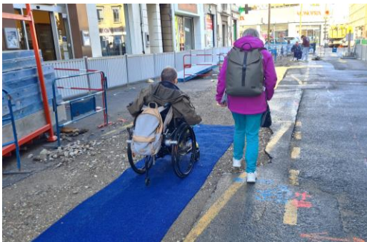
Test d'un tapis de chantier
