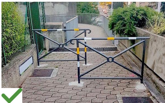
Barrières détectables et contrastées franchissables par une PMR
