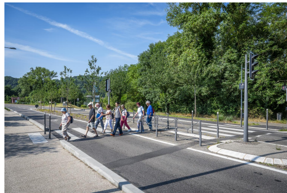
Piétons traversant sur un ilot en baïonnette
