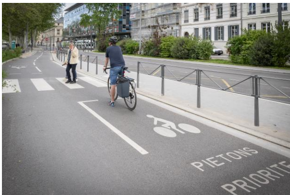
Exemple de signalisation complémentaire marquée sur la piste pour améliorer le respect de la traversée piétonne
