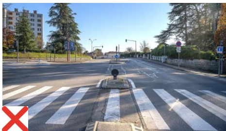
Ilot technique qui a été aménagé de façon contraire aux préconisations métropolitaines
