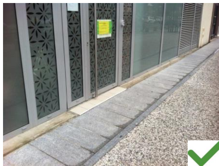
Le dallage le long de la façade créé un repère pour les personnes déficientes visuelles
