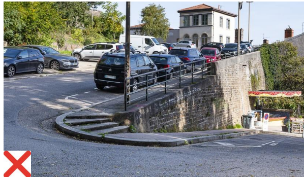
Escalier qui risque de surprendre un piéton déficient visuel : l'implantation d'une bande d'éveil de vigilance ici est pertinente
