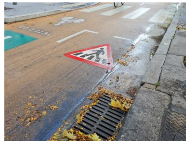
Marquage au sol d'un A13b sur une Voie Lyonnaise
