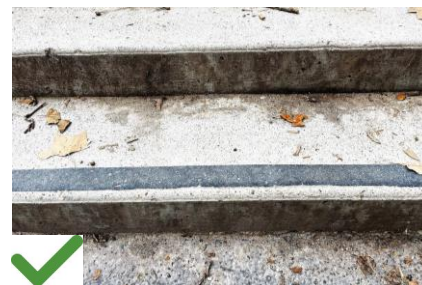
Exemple de nez de marche conforme à la réglementation
