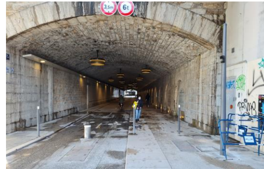
Balise sonore à l'entrée d'un tunnel modes actifs : elle délivre des informations sur la longueur et le fonctionnement de l'aménagement
