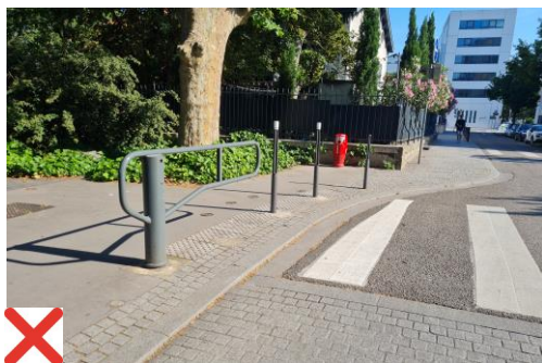
Barrière pivotante positionnée dans le cheminement piéton
