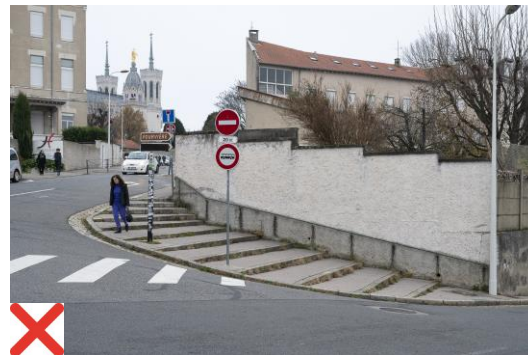
Exemple d'escalier en pas d'âne interdit par la réglementation
